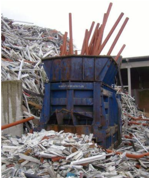
Bild 66: PVC-Rohre in Schere
